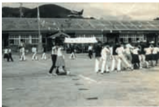
現在の場所に移転した後の木造校舎
